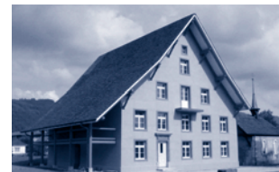
Adam Zeltner-Haus mit St. Jakobskapelle, Oberbuchsiten. Die Renovation der «Schälismühle» wird vom Solothurner Heimatschutz unterstützt. 2003 konnte die Aussensanierung des Adam Zeltner-Hauses abgeschlossen werden. Foto: Genossenschaft Schälismühle, Oberbuchsiten
