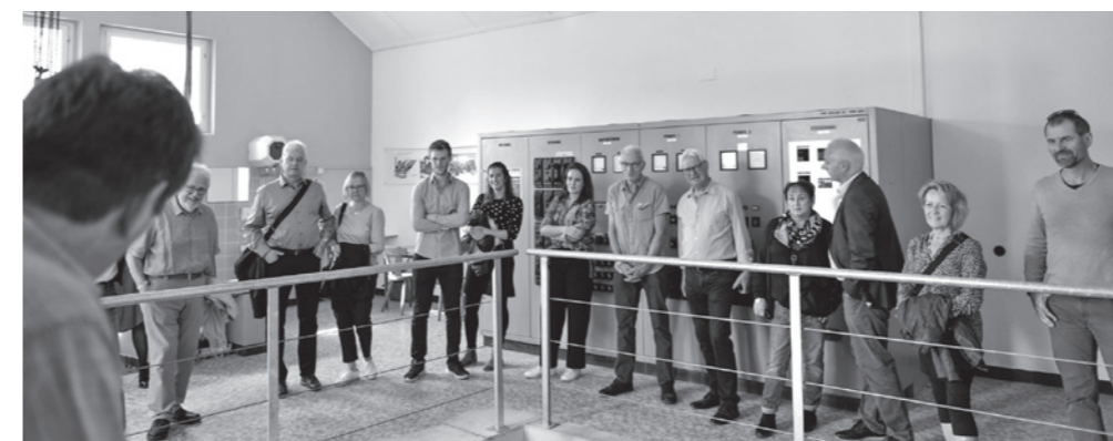
Im Innern des Kleinwasserkraftwerks in Grenchen
